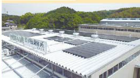
工場の屋根に設置した太陽光発電パネル
