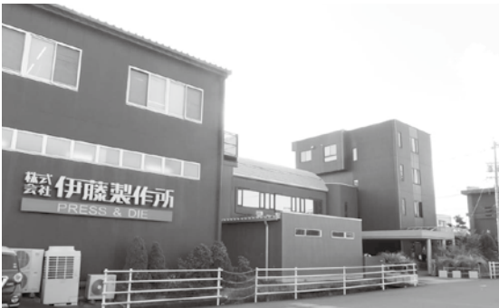
四日市の工業団地に建ち地域への貢献度も高い伊藤製作所
