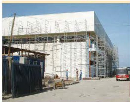
建設中のフィリピン第一工場
